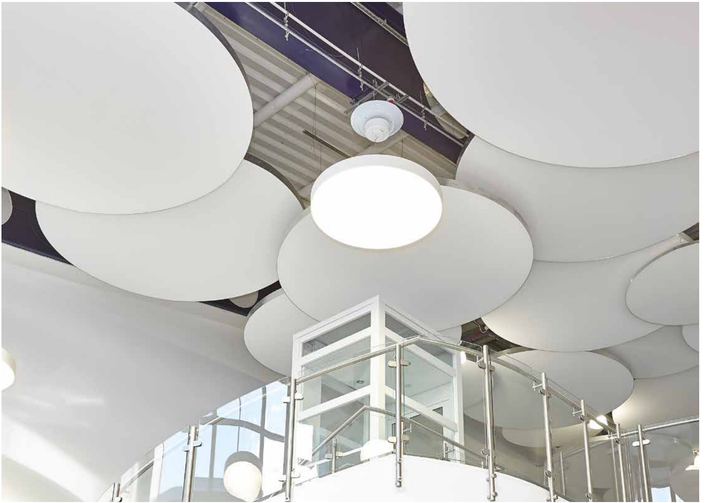
Ecole Haberdasher, Royaume-Uni. 37 cercles de différents diamètres : de 2,00 m à 5,00 m. Ep. : 43, 100 et 140 mm. Revêtement blanc et absorbant acoustique.
